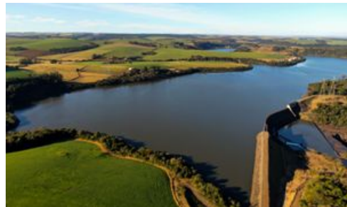
Usina Quebra queixo – São Domingos SC
