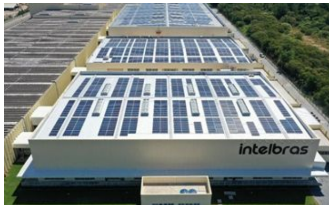
Maior Usina solar em cobertura (atualmente). Intelbras, em São José - SC
