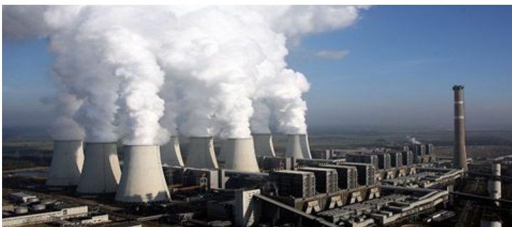
Usina termelétrica de Jänschwalde, na Alemanha.
